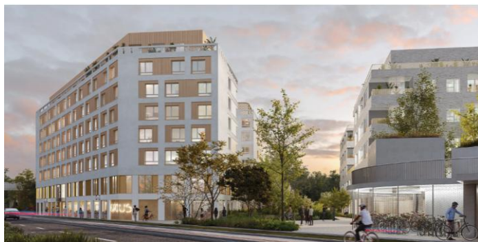
Construction de 237 logements à Créteil résidence CTC quartier de gare du Grand Paris Express « Le Vert de Maisons » (RER C et future ligne 15)
